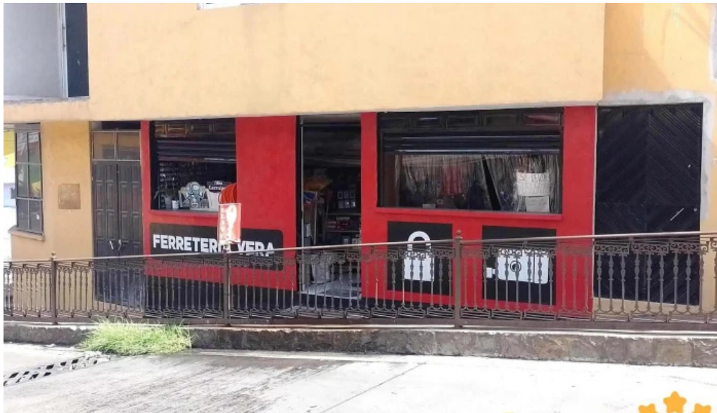
Ferreterías y cerrajerías vera del propietario
