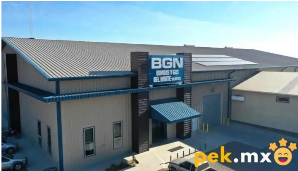
Bombas y gas del norte cuauhtemoc
