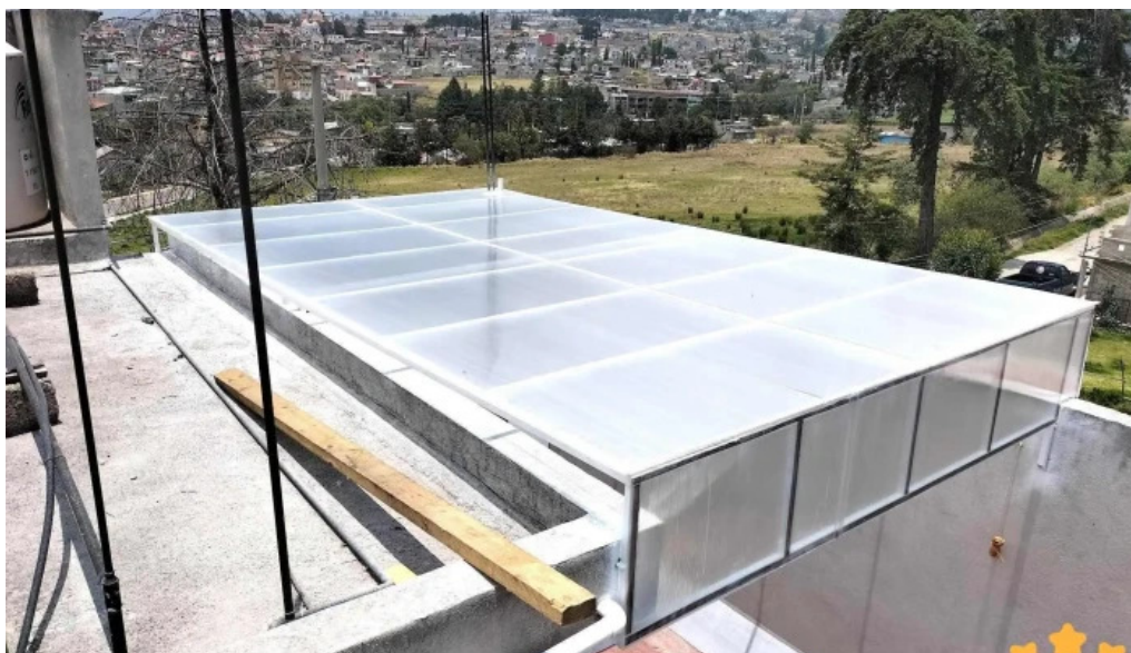
Refrigeracion electricidad y plomeria del propietario
