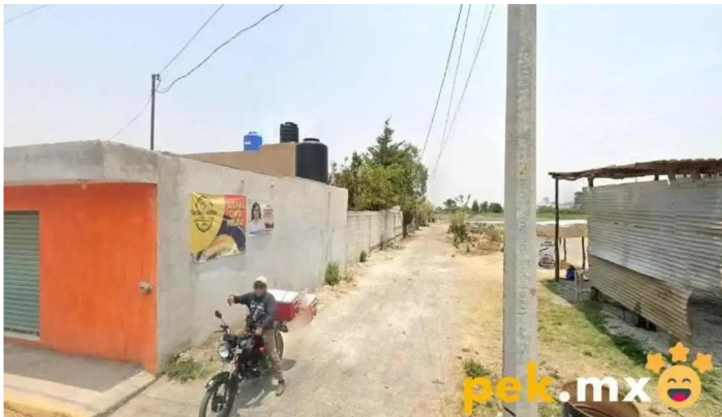
Chalma servicio electrico santa maria malacatepec
