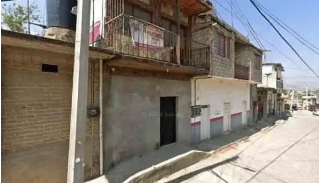
Servicio electrico noel ubicacion
