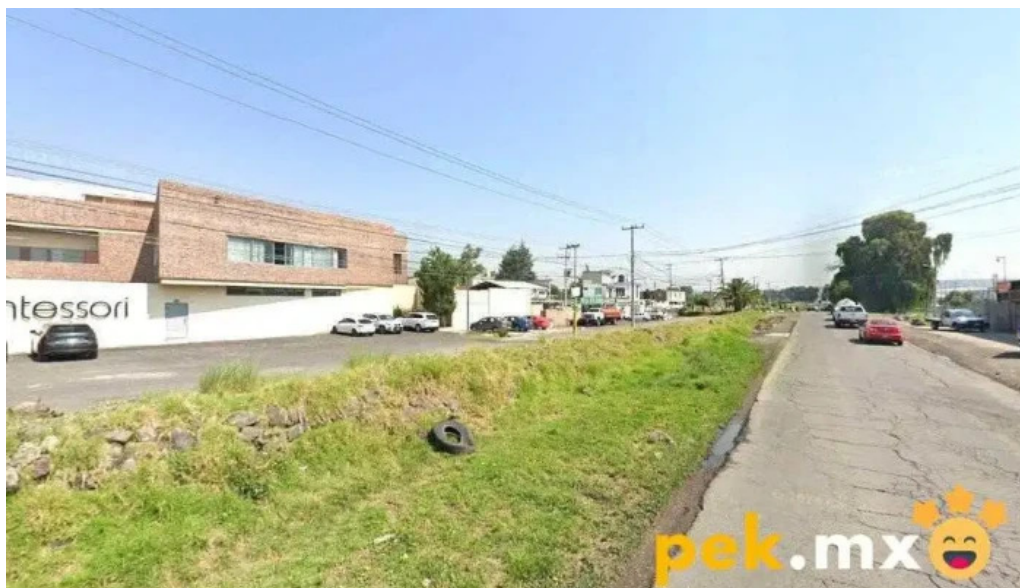
Servicio electrico jorges el pedregal de guadalupe hidalgo
