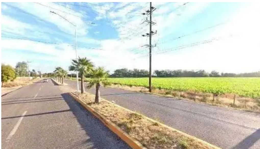
Subestacion cfe de pericos sin sitio web
