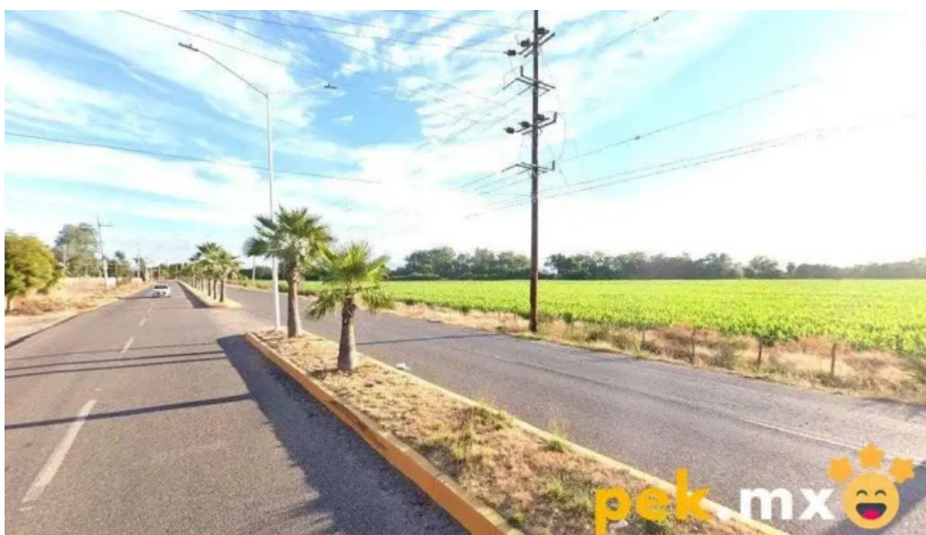
Subestacion cfe de pericos sin pericos
