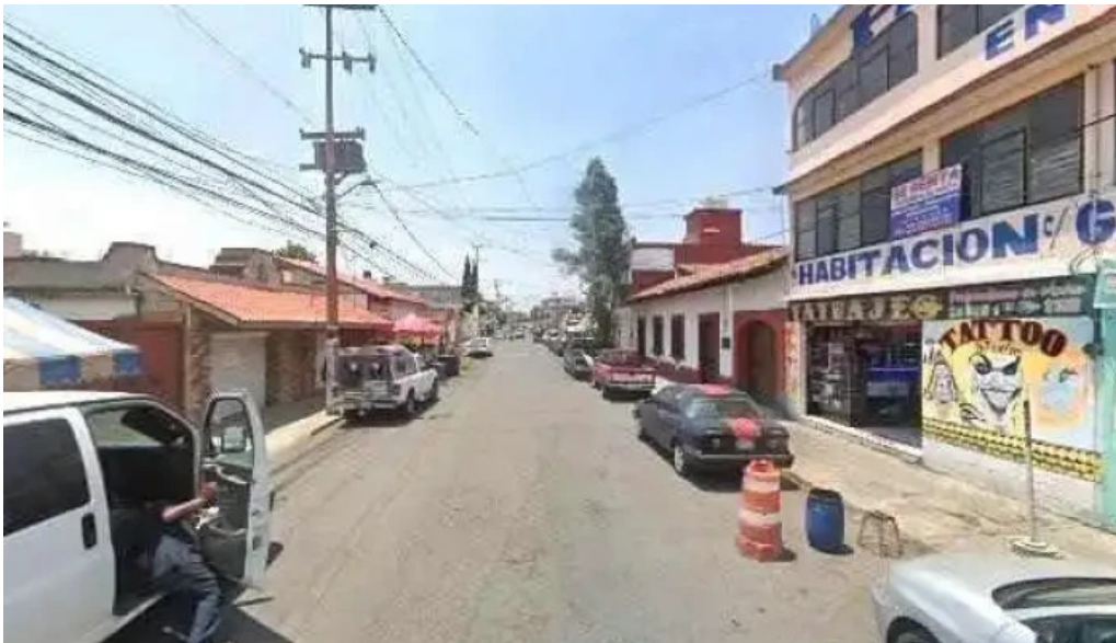
Servicio electrico izquierdo direccion
