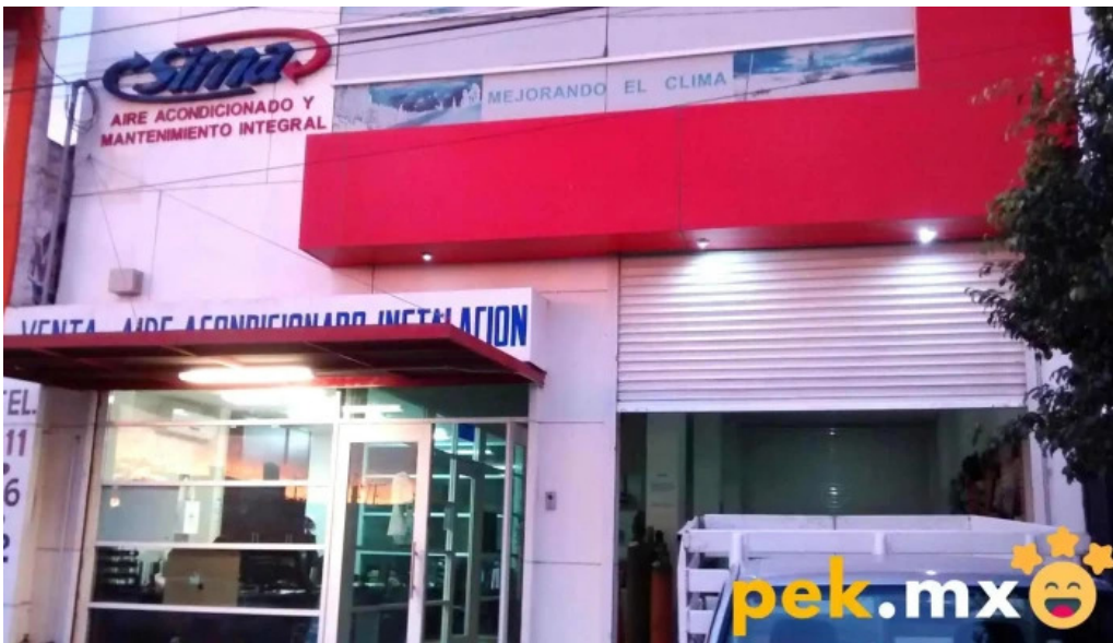
Sima aire acondicionado y mantenimiento integral exterior
