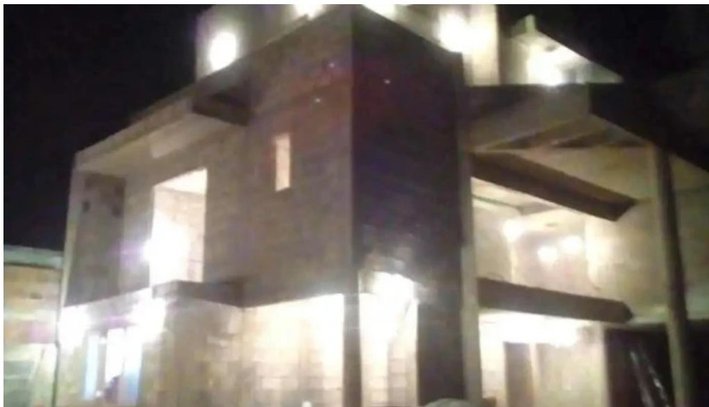
Servicios de electricidad el toques exterior
