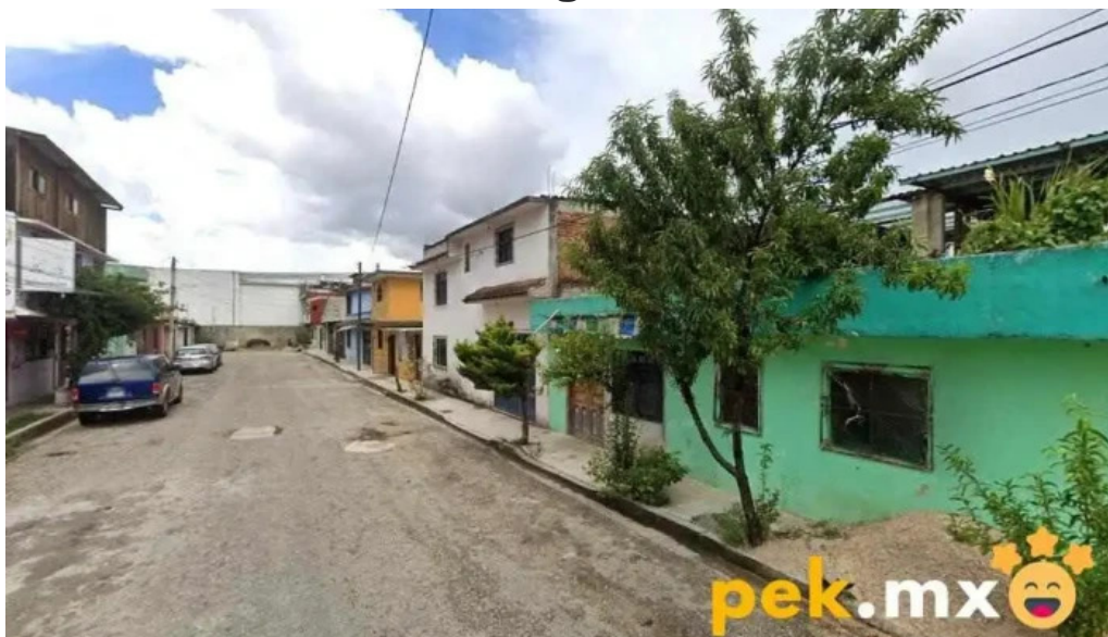
Edfa instalaciones san cristobal de las casas
