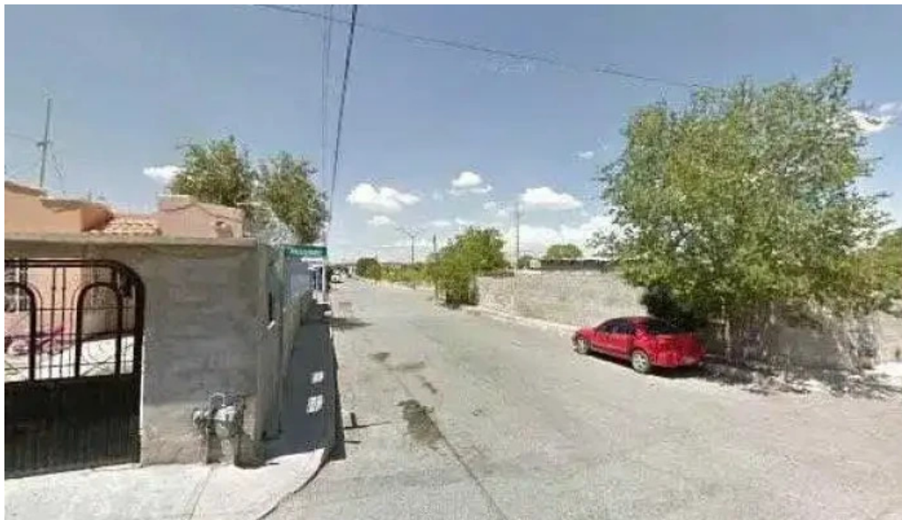
Instalaciones electricas siem telefono
