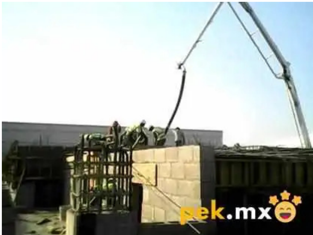
Cae instalaciones industriales cae centro de atencion electrica sa de cv heroica puebla de zaragoza
