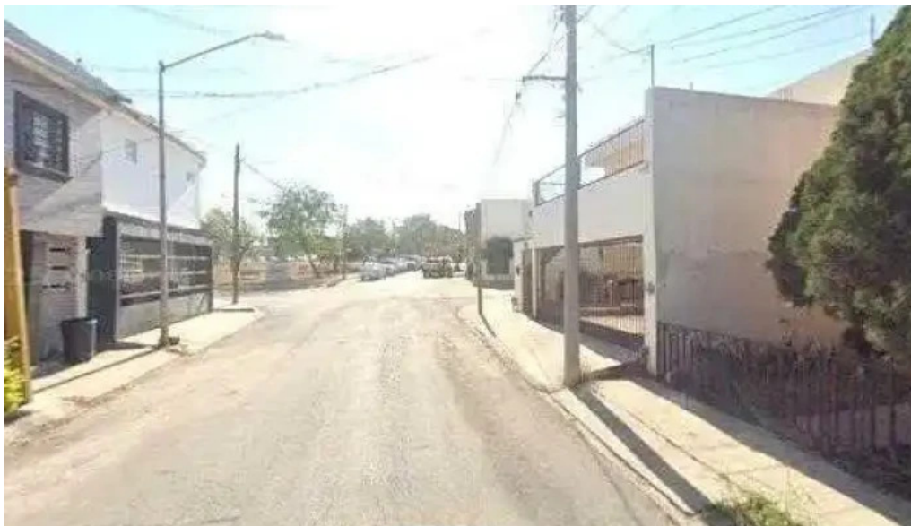
Cerco electrico zona
