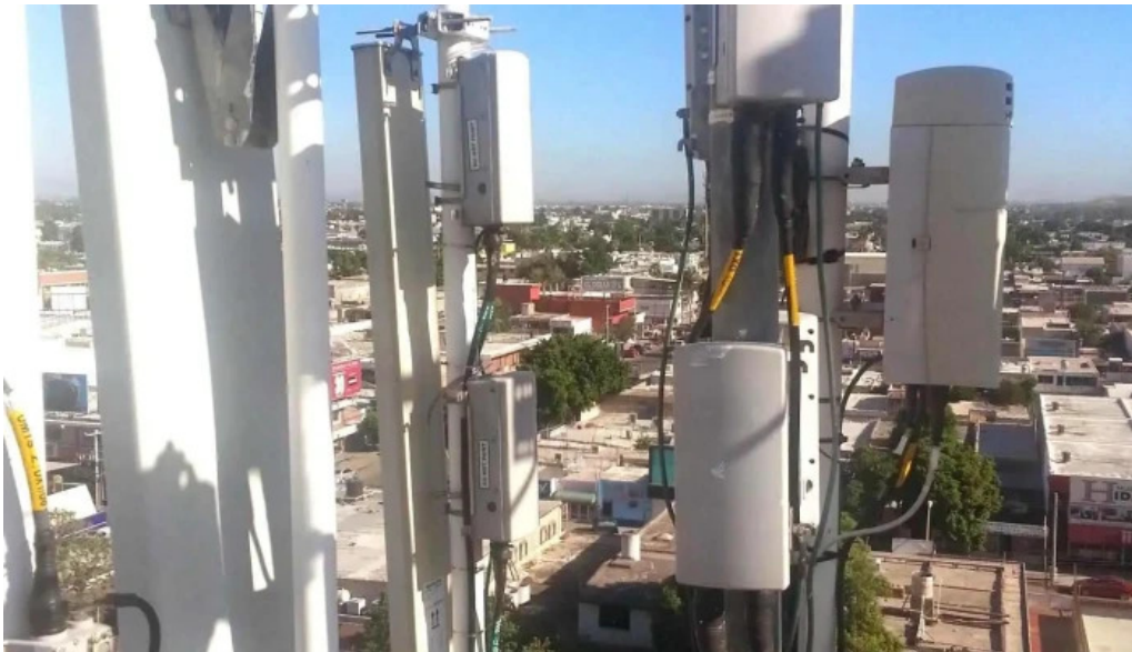
Electro instalaciones corporativo s c direccion
