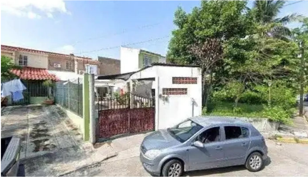
Servicios de mantenimiento del golfo semago telefono
