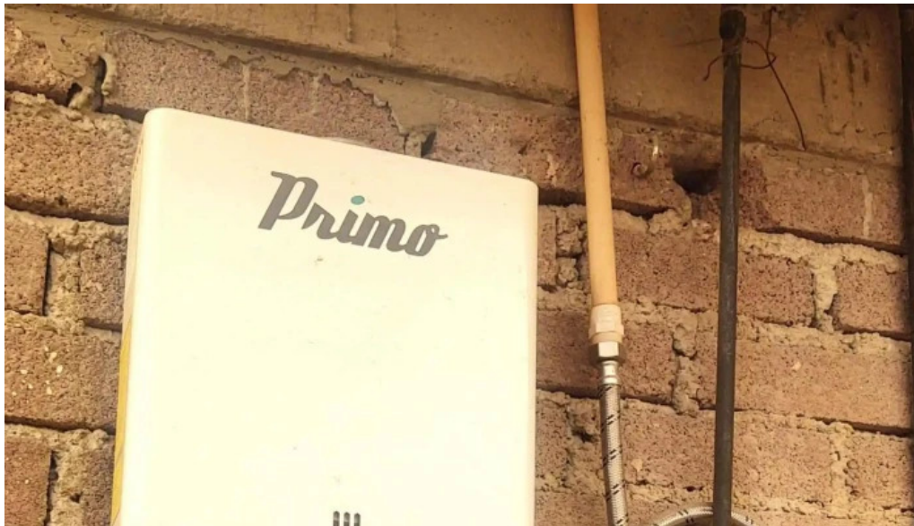
Bombas reyes servicio de bombas de agua plomeria y electricidad mexico
