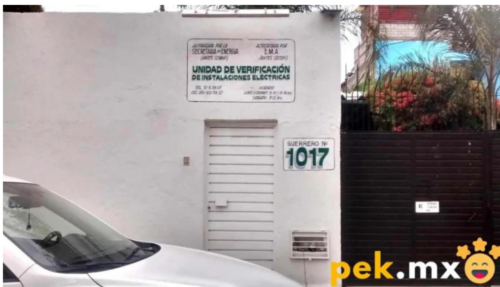
Unidad de verificación de instalaciones eléctricas famen fotos
