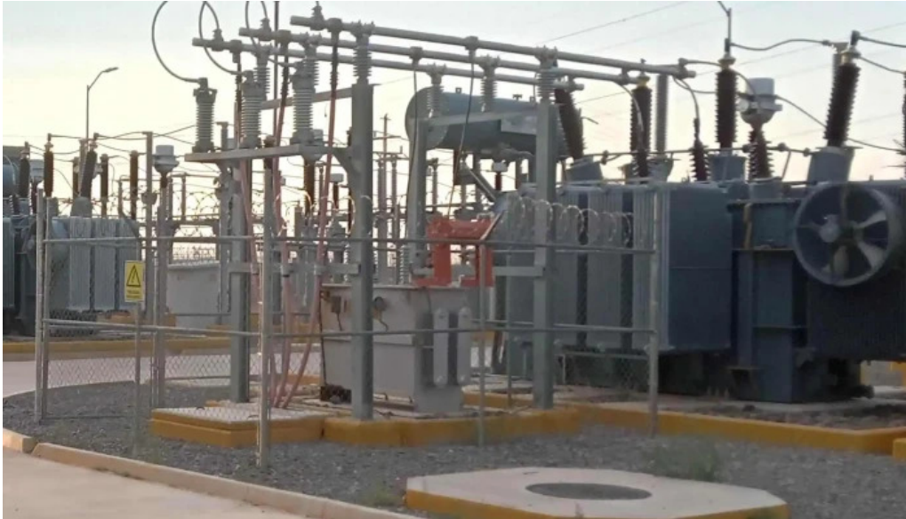
Parque fotovoltaico las ahumadas cerca de mi
