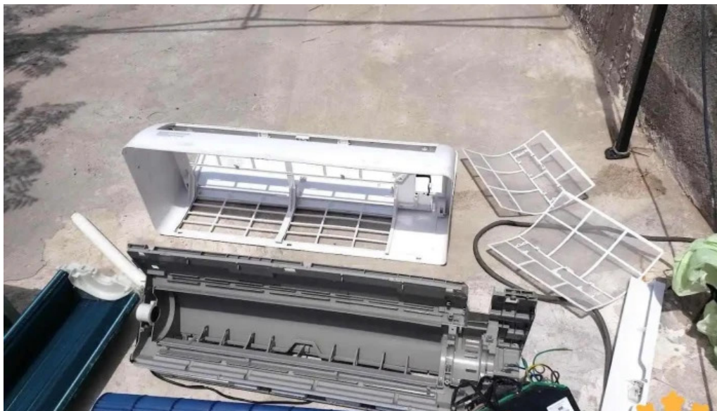
Electricistas de juarez juarez
