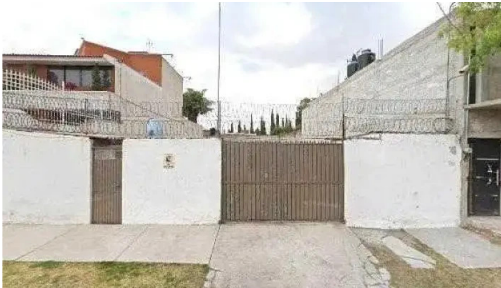
Maga instalaciones y proyectos electricos sa de cv como llegardeg
