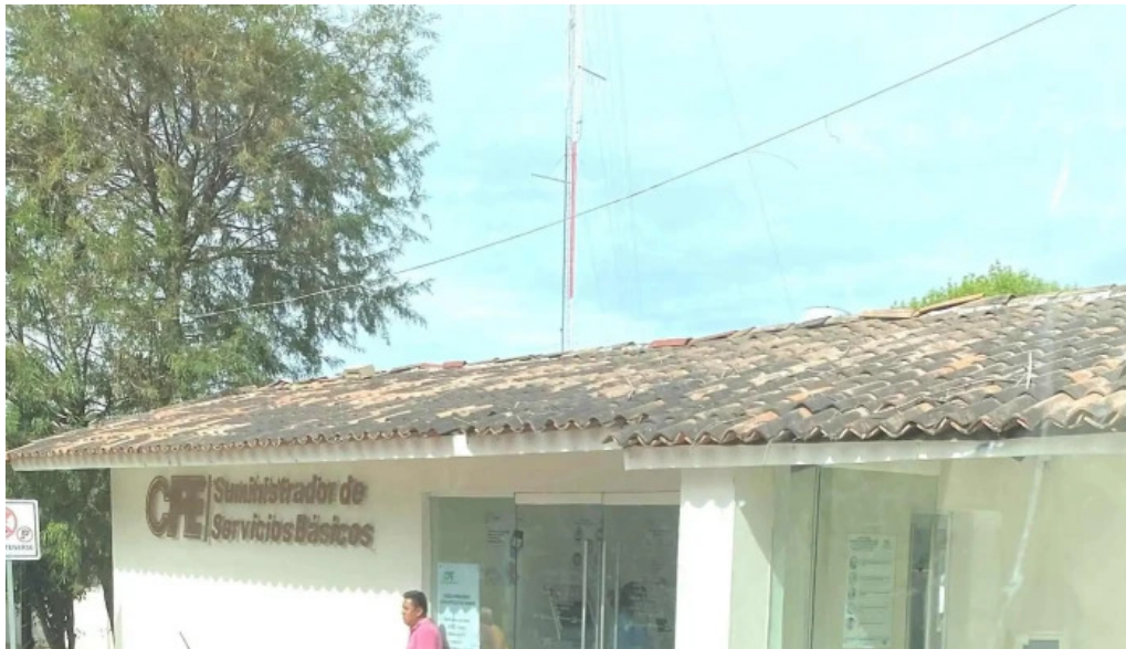
Centro de distribucion cfe zona valle de bravo zona
