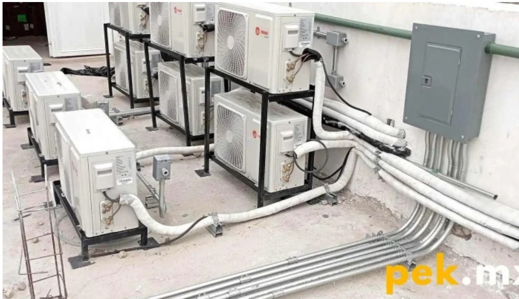
Franher electricidad interior
