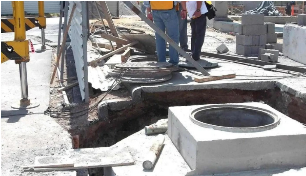
Proyectos y construcciones electricas hormigon
