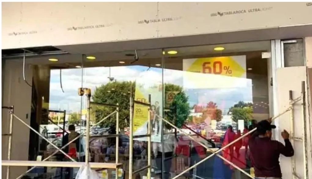
Mic multiservicios mantenimiento innovacion y construccion exterior
