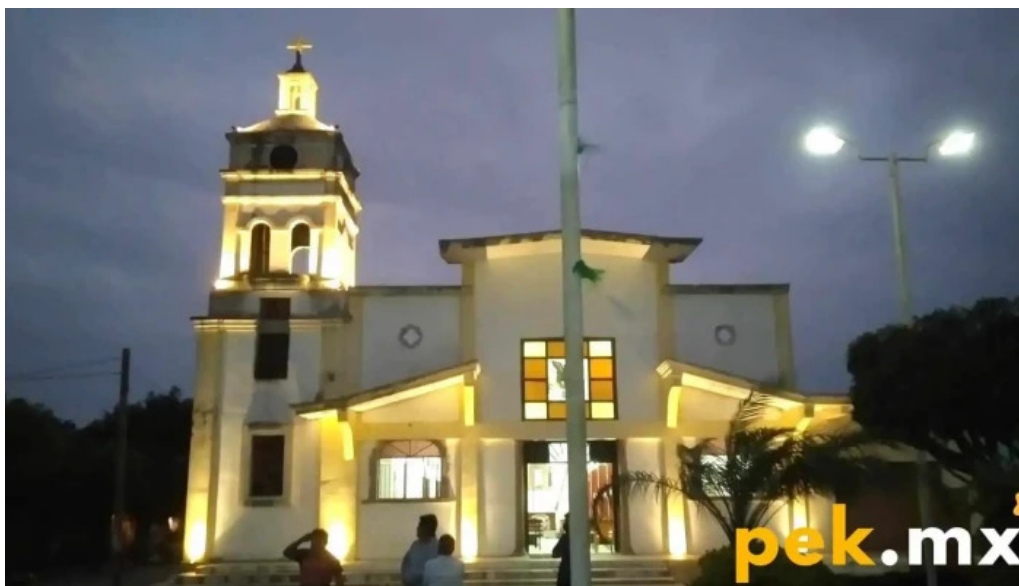
Elecmart instalaciones electricas exterior
