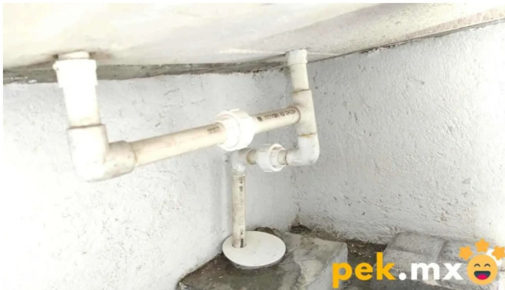
Reparaciones hernandez plomero electricista interior
