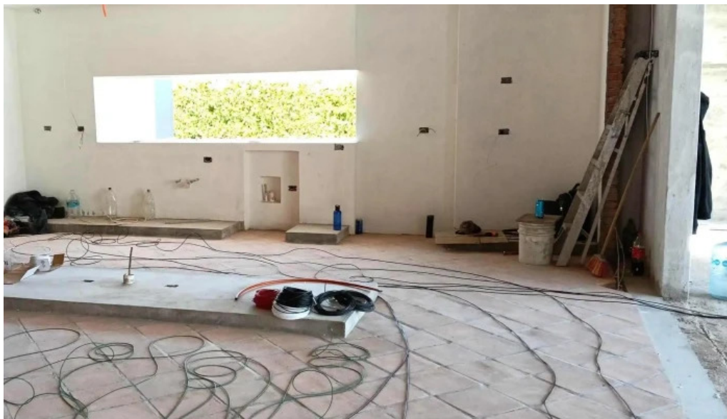
Instalaciones integrales magno santa clara huitziltepec
