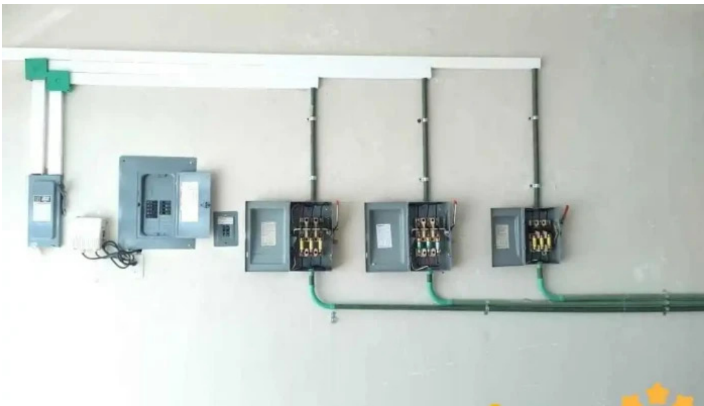
Servicios de plomeria y electricidad beltran telefono
