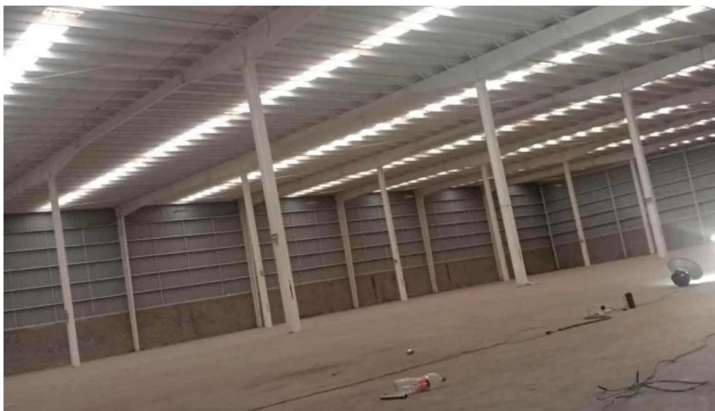
Instalaciones electricas para el hogar del propietario
