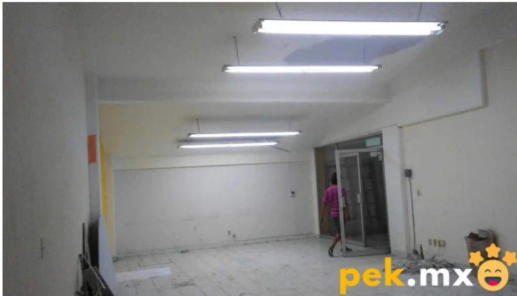
Electricidad y plomeria en morelia interior
