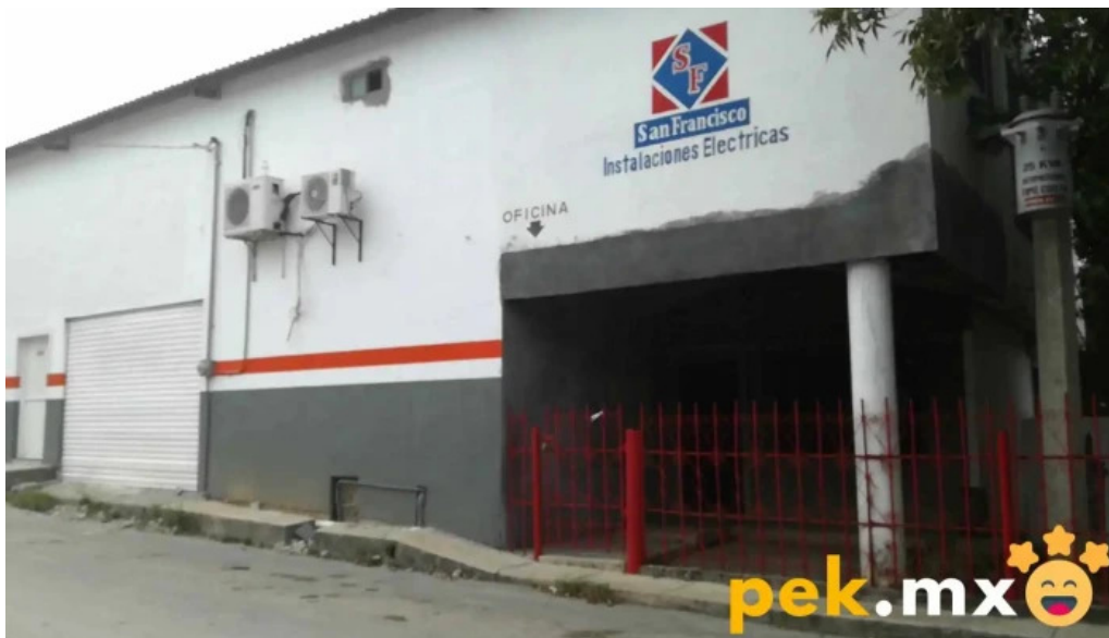
Instalaciones electricas san francisco promocion
