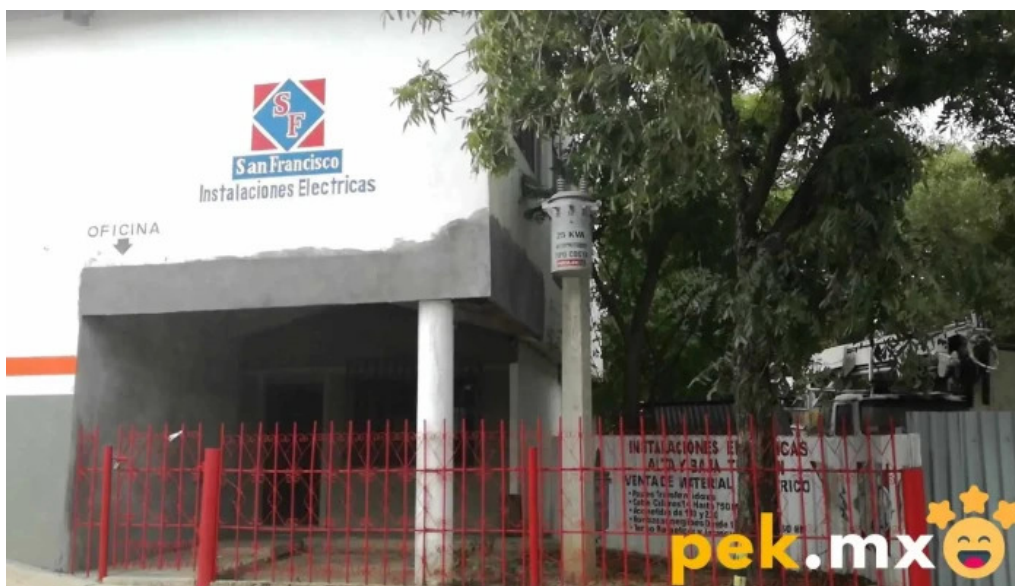
Instalaciones electricas san francisco exterior
