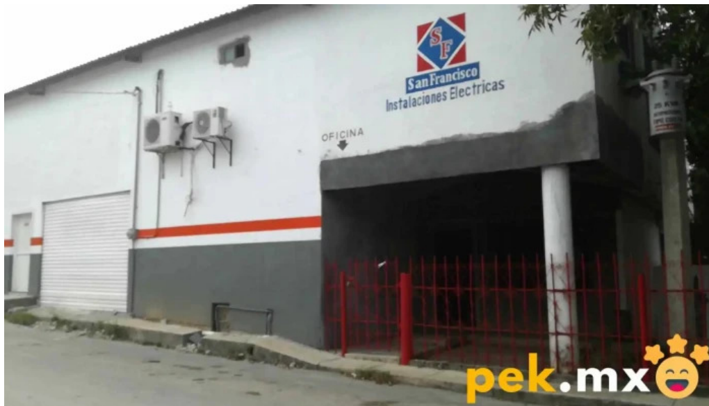
Instalaciones electricas san francisco montemorelos
