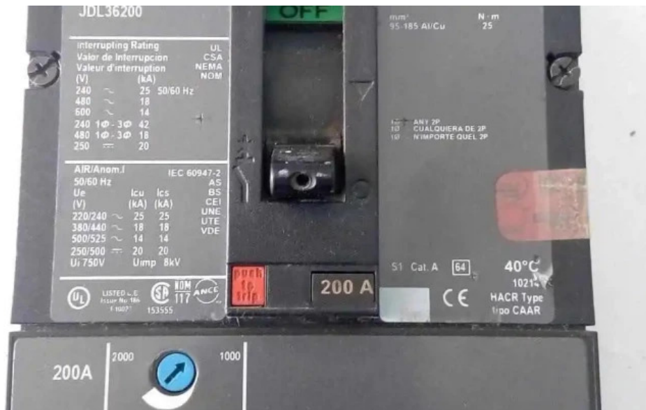
Electricistas siec servicio integral de electricidad y control mas recientes
