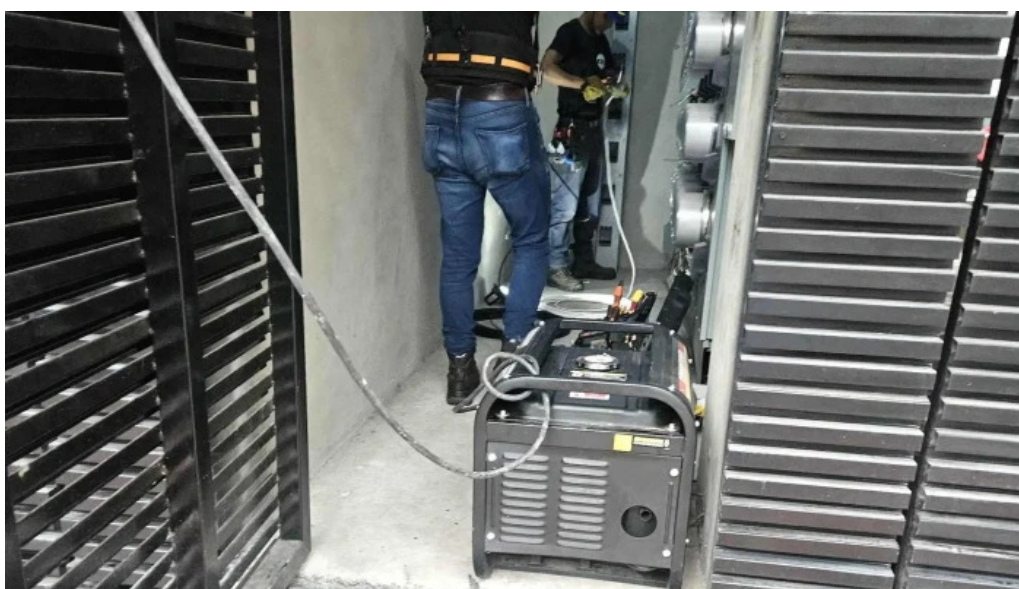
Phi servicios electricos puntaje
