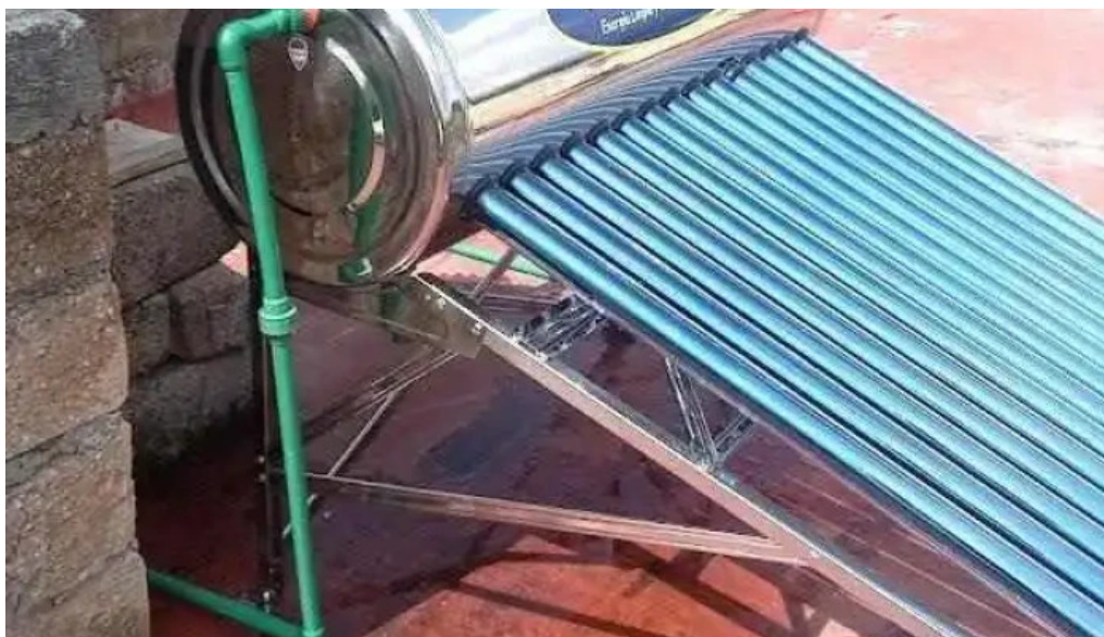
Servicio plomeria y electricidad metepec
