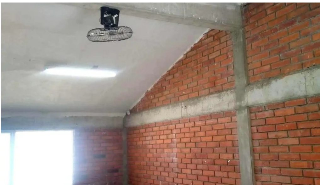
Instalem instalaciones electricas mireles interior
