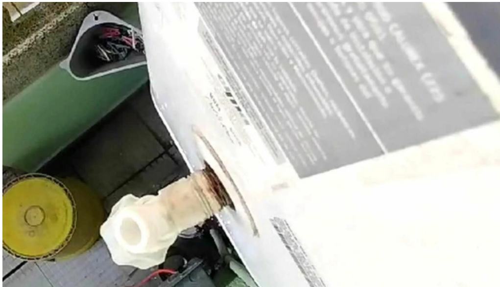
Plomero y electricista coacalco servicio metelec descuentos
