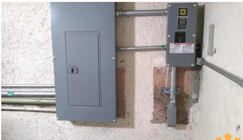
Electricista paneles solares emiliano zapata
