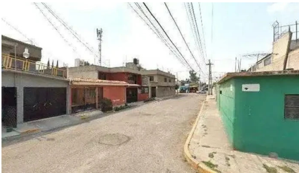
Contratista en instalaciones electricas industriales y residenciales en general fotos
