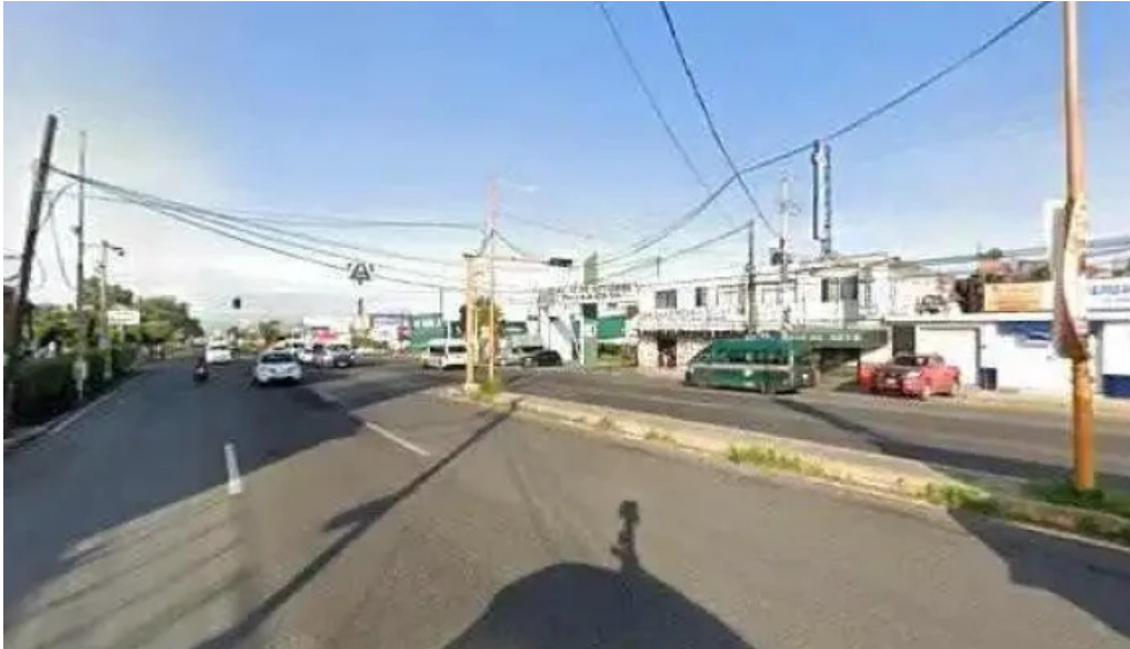
Electrica brisas sitio web
