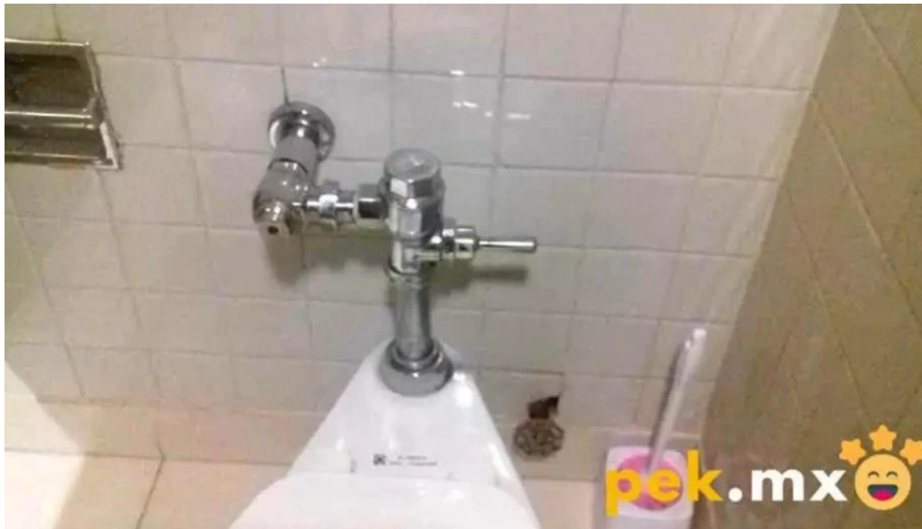
Taller de plomeria y electricidad interior
