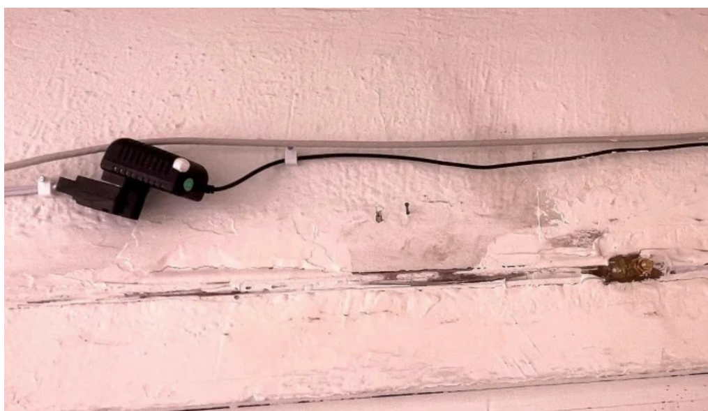
Taller de plomeria y electricidad cuauhtemoc ciudad de mexico
