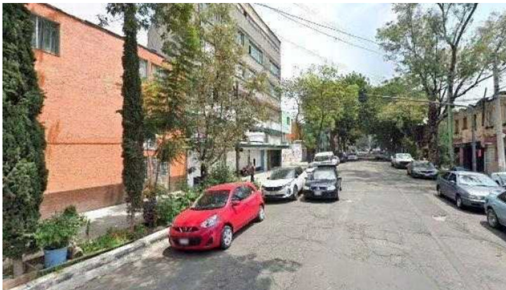
Comercializadora electrica palacios fotosdeg
