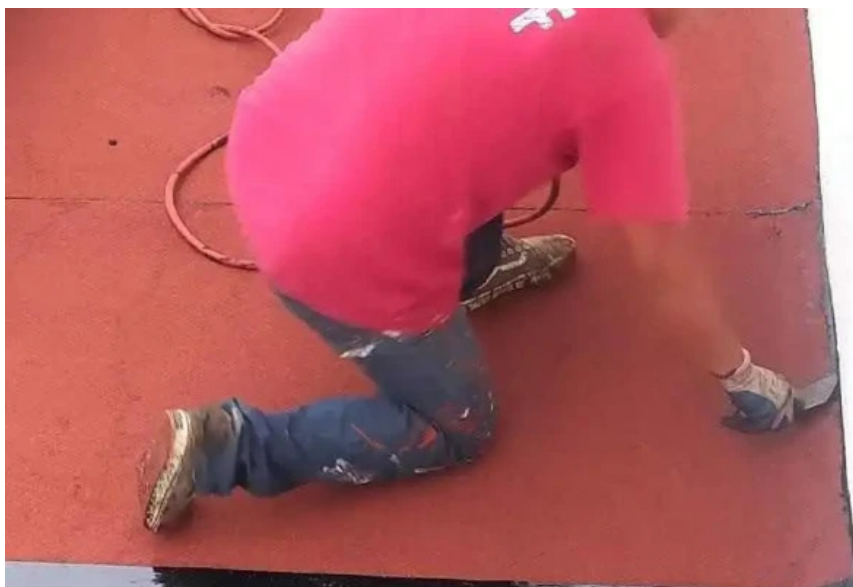
Plomeria y electricidad calvo remodelaciones acabados pintura del propietario
