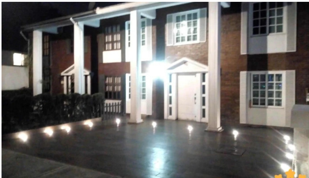
Plomeria y electricidad calvo remodelaciones acabados pintura exterior
