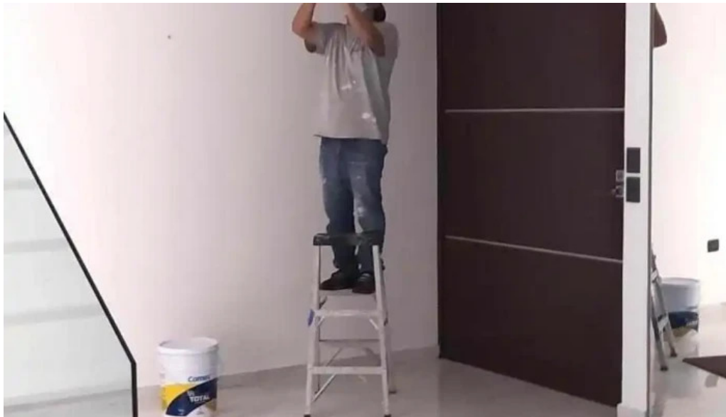
Plomeria y electricidad calvo remodelaciones acabados pintura interior
