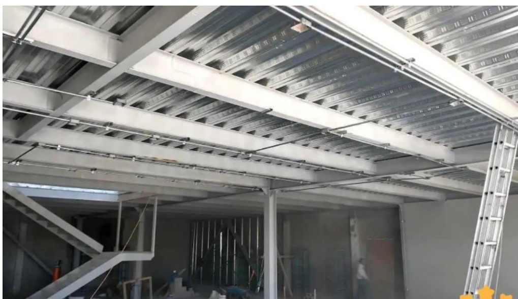
Instalaciones electricas industrial y residencial en baja y media tension chimalhuacan
