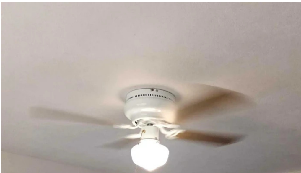
Instalaciones electricas y de refrigeracion riem chihuahua
