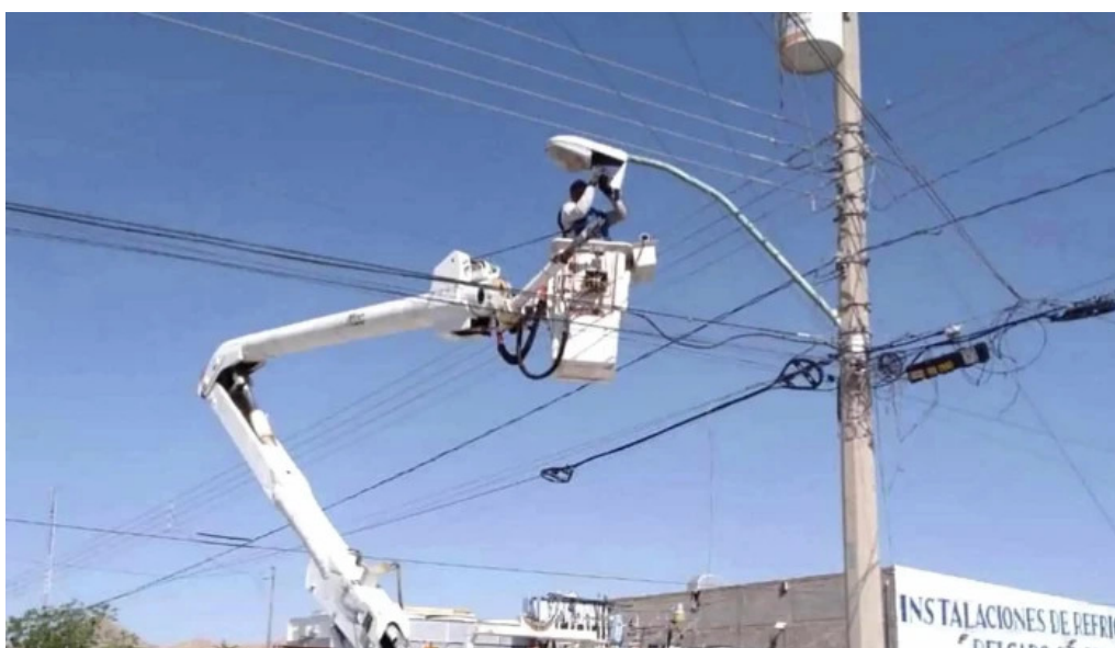
Instalaciones electricas y de refrigeracion riem horario
