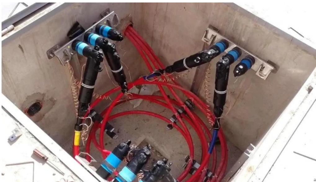
Instalaciones electricas y de refrigeracion riem del propietario
