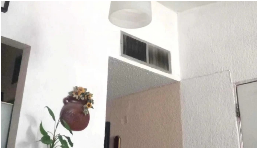
Instalaciones electricas y de refrigeracion riem promocion
