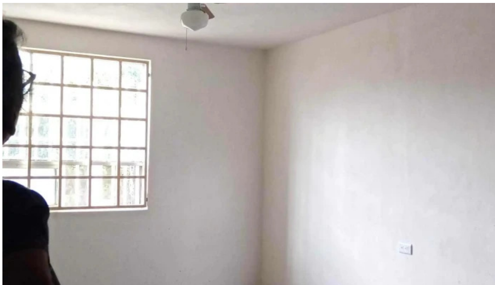
Instalaciones electricas y de refrigeracion riem ubicacion
