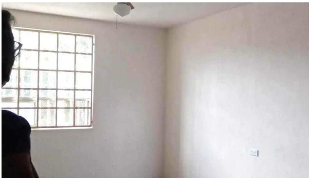
Instalaciones electricas y de refrigeracion riem interior
