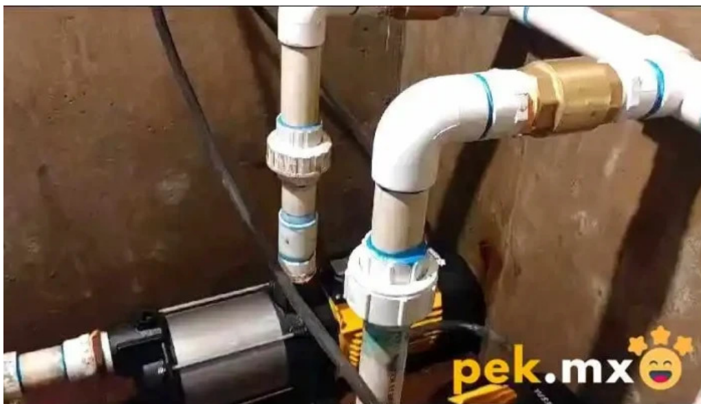
Plomeria y electricidad torres del propietario
