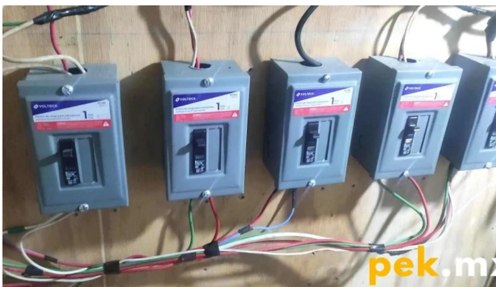
Plomeria y electricidad torres telefono
