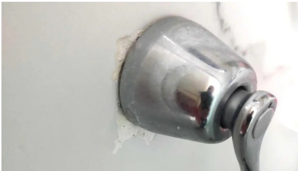
Electricista plomeria y reparacion de boilers yoloxochitl numero
