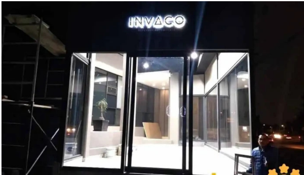
Electricista instalacion mantenimiento exterior
