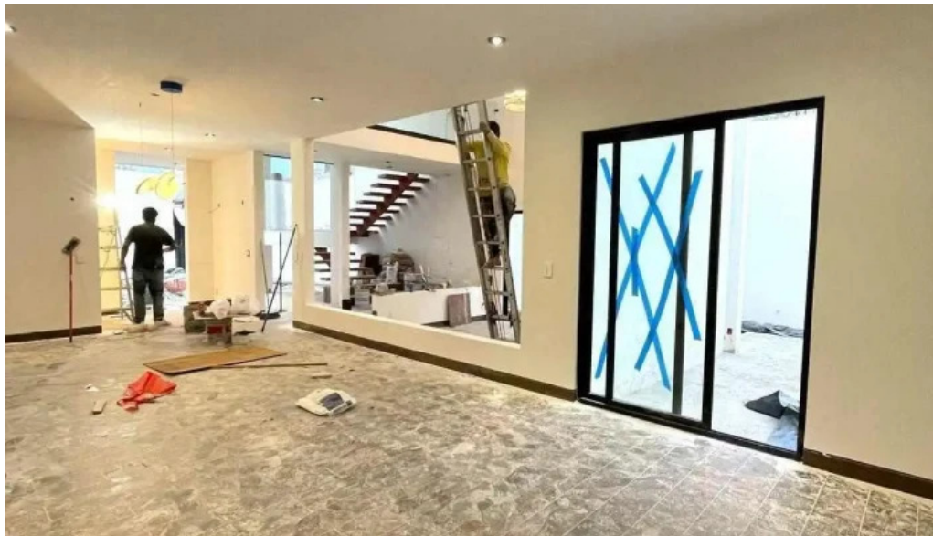
Electricista instalacion mantenimiento interior
