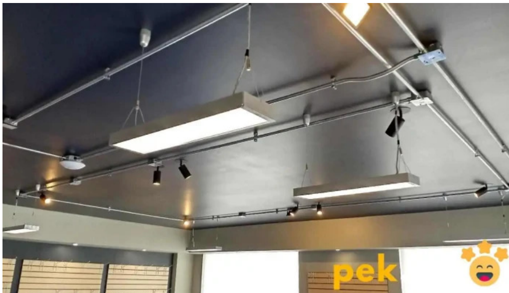
Electricista instalacion mantenimiento benito juarez ciudad de mexico
