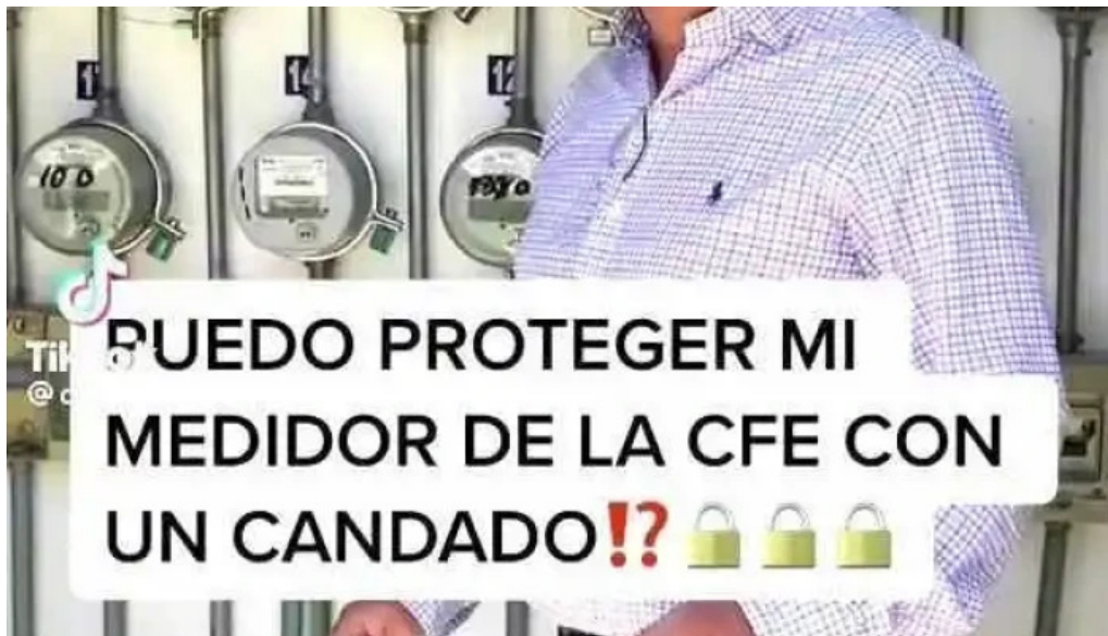
Electricista en general del propietario
