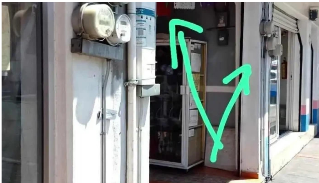
Electricista en general exterior
