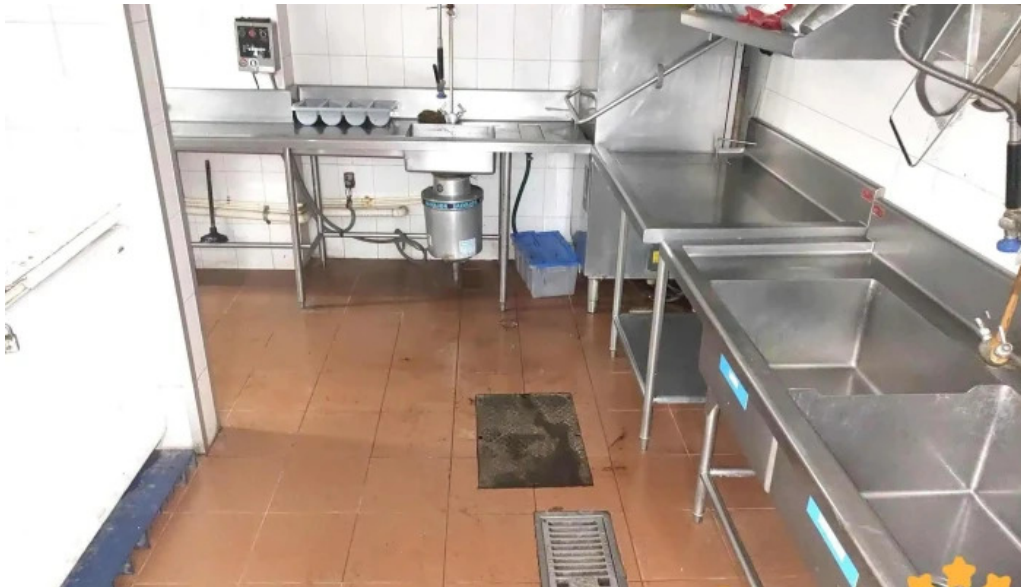
Plomeria y electricidad rodriguez interior
